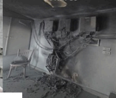
Incendie des onduleurs de nos panneaux solaires
